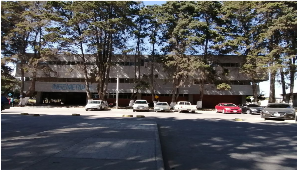
Figura No. 2 Fotografía del Módulo G.
